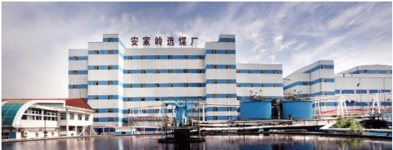
生产能力超过2000万吨的安家岭选煤厂
