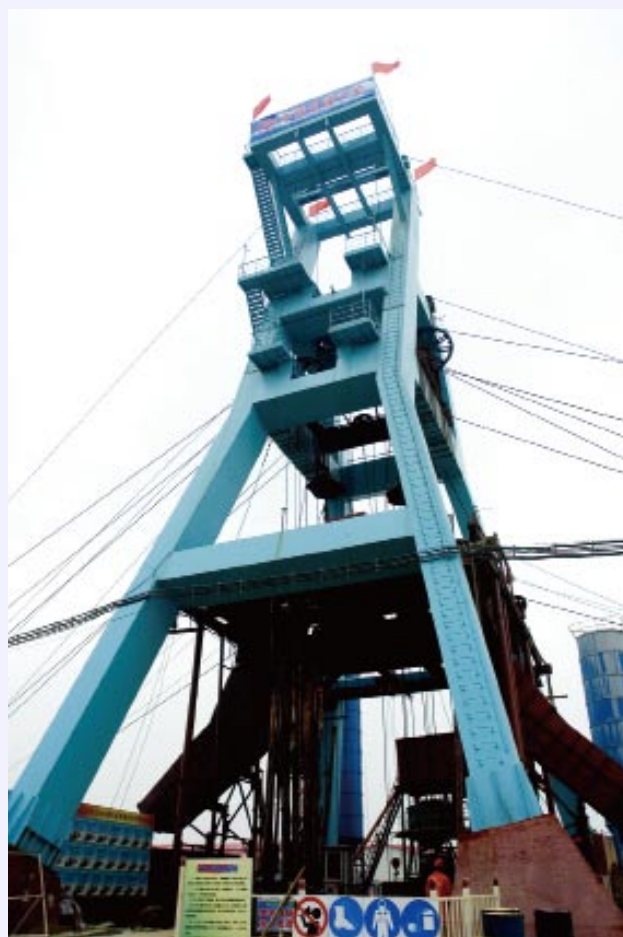
煤矿立井施工
