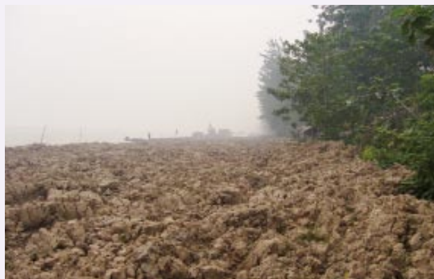
大屯矿区塌陷区回填复垦
