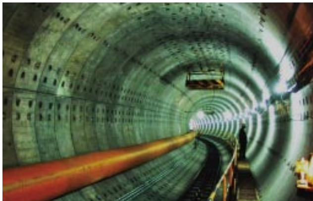
城市地铁施工
