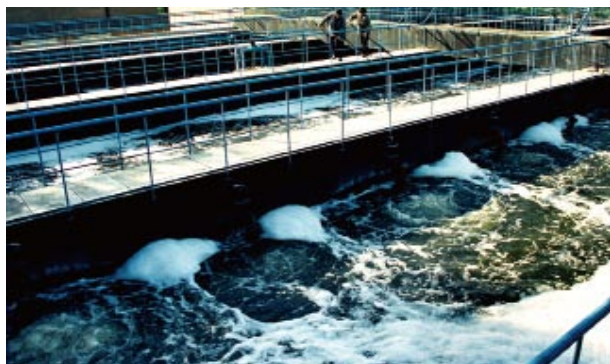
平朔公司污水处理
