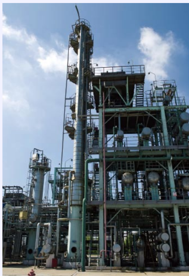
中煤龙化公司25万吨甲醇装置建成
