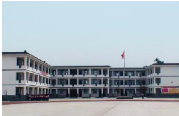
中煤集团援建成都市金堂县龙威小学
