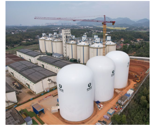
建设集团承建的成都中央储备粮四川新津直属库全球首座架空“粮食气膜仓”被誉为“国之重器”工程
