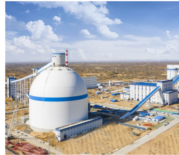
建设集团承建的大海则煤矿原煤球形气膜仓
